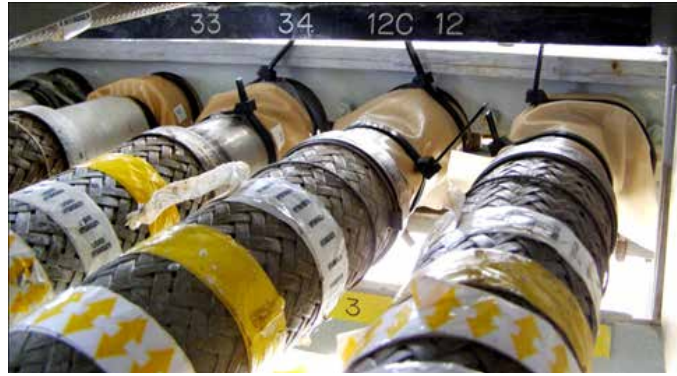
รูปที่ 4 เทปตรวจสอบการรั่วไหลของก๊าซไฮโดรเจน ที่มา https://www.nasa.gov/content/innovative-hydrogen-leak-detection-tape-earns-prestigious-award
